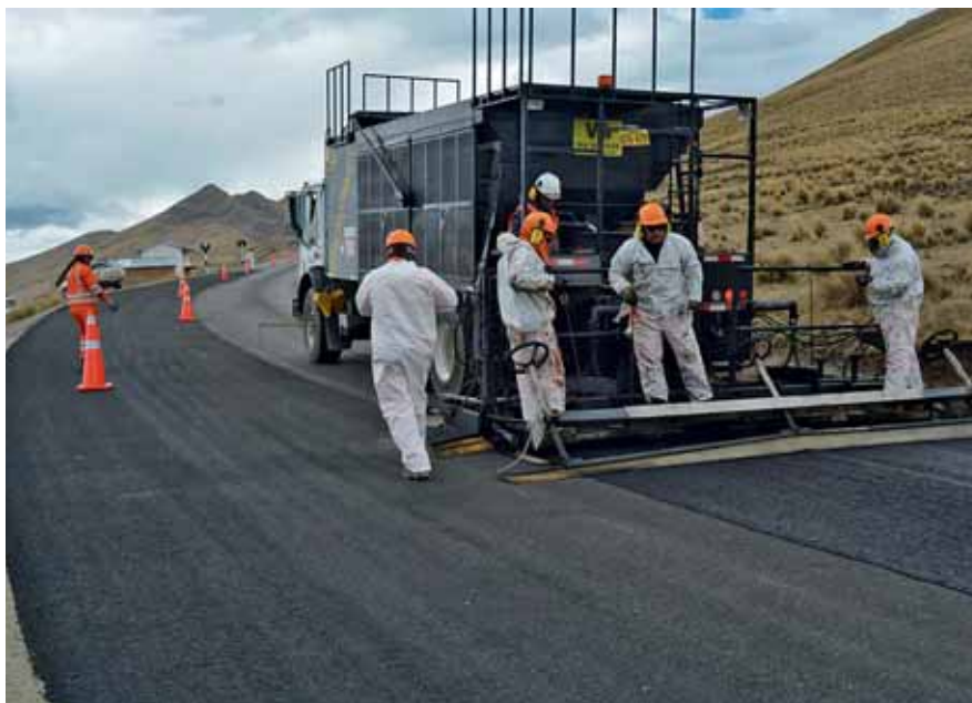
Mejora y mantenimiento de vías en la ruta Las Bambas - Espinar.
